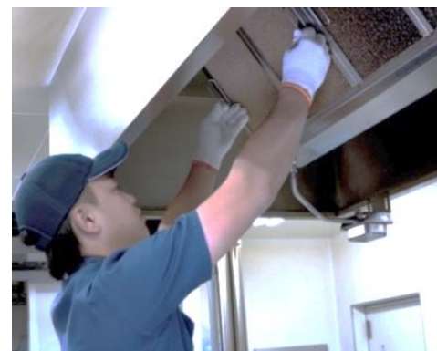
厨房でのフィルター交換作業
