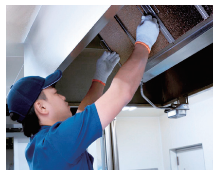
厨房でのフィルター交換作業
