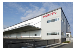
モリト関東ロジスティクスセンター
